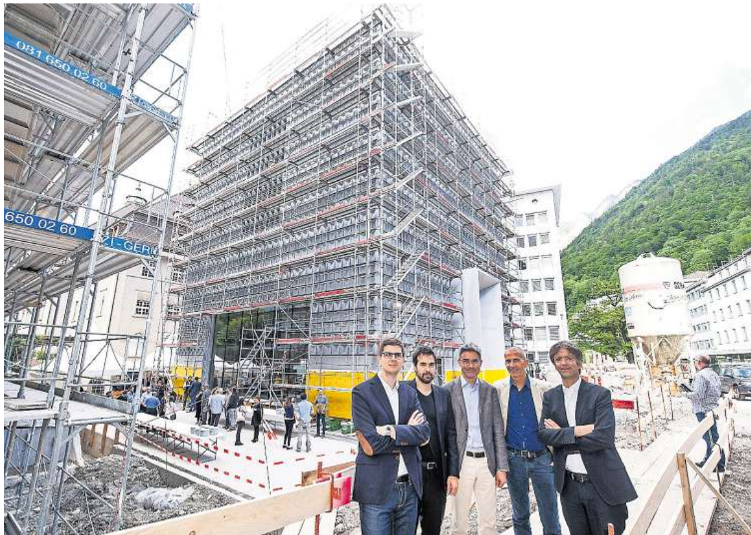
Die Architekten und ihre Bauherren: Alberto Veiga, Fabrizio Barozzi, Mario Cavigelli, Markus Dünner und Stephan Kunz (von links) vor dem Rohbau des Bündner Kunstmuseums. (FOTO OLIVIA ITEM)
