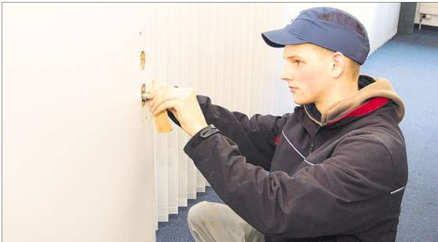
Die Aufgaben von Andrin Christoffel, Lernender Fachmann Betriebsunterhalt EFZ im 3. Lehrjahr bei Ems-Chemie, umfassen Arbeiten wie Türschlösser auswechseln ...
